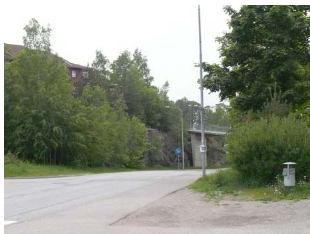
....och cykelbro i Östra Orminge
